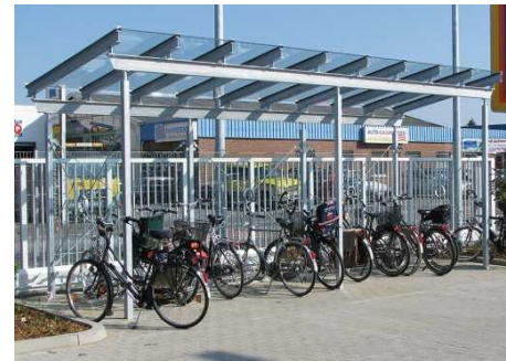
Überdachte Fahrradabstellanlage WSM GmbH, Modell „Passau“
